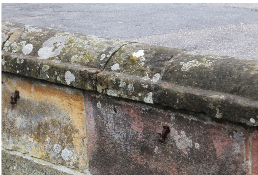
Detailansicht der als Abdeckung verwendeten römischen Zinnensteine
